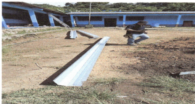
Foto1: Trabajando y cambiando los canales.
