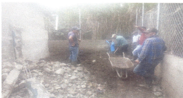
Foto 3: Trabajando del baño que estaba mal.
