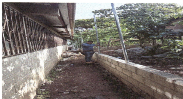
Foto 4: Dando mantenimiento la construcción del perímetros.
