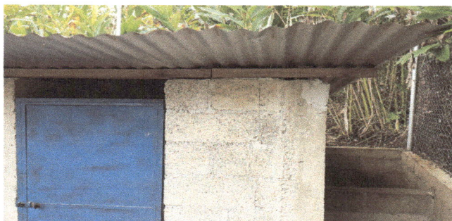
Foto 5: Se cabio las puertas del baño.
